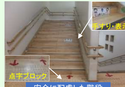
安全に配慮した階段
